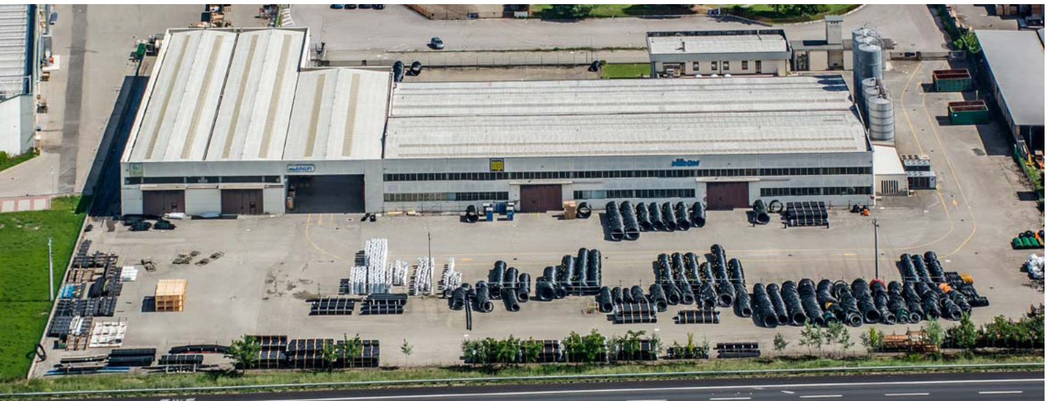
Centre Opérationnel - Imola (BO)
