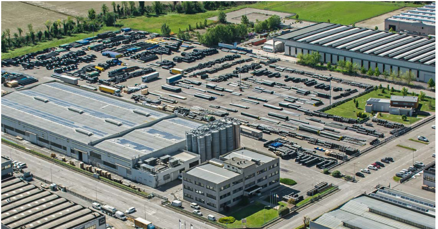
Centre Opérationnel - Castel Guelfo di Bologna (BO)
